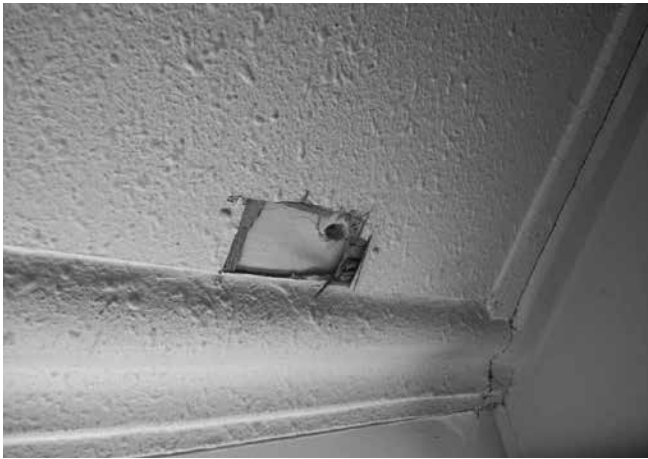
写真 14 改修前大天井の合板下地吹付け仕上げ面
