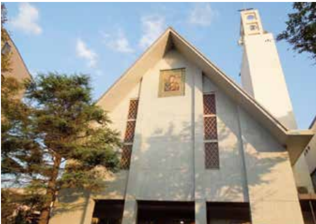
写真5 カトリック雪ノ下教会外観
