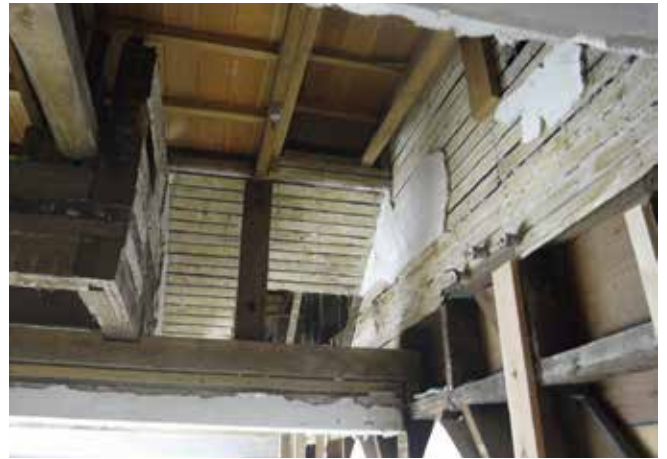
写真10 改修前の内壁木摺下地と残存漆喰仕上げ
