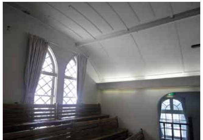
写真11 改修前天井端部の湾曲部。合板下地に吹付け仕上げ
