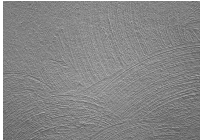
写真 15 改修後の軍手での掌による漆喰撫で塗り仕上げ面
