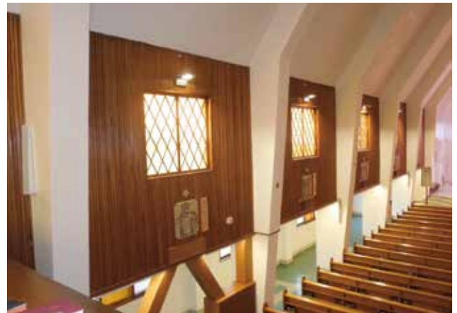
写真8 側廊上部。隔柱際に縦長スピーカーを片側ずつ4個設置
